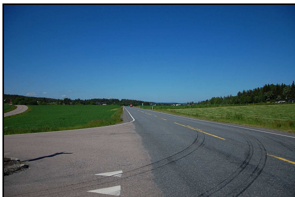
Krysset Fv141xRv35, sikt mot nord.
